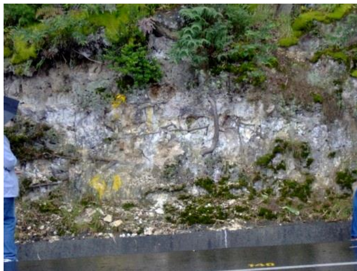
Foto 16. Altiplano de Las Palmas. Perfil típico en la Autopista al aeropuerto. Lote 368.
