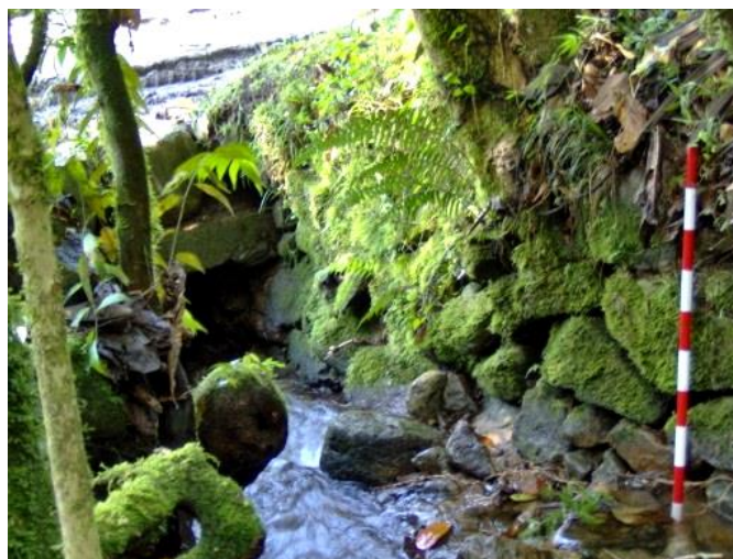
Foto 52. Adecuación en piedra del puente sobre la quebrada El Atravesado.
