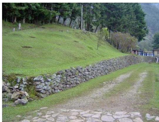
Foto 45. Vallado en carreteable dentro del colegio
