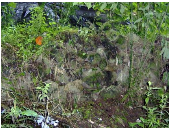
Foto 47. Vallado en piedra cerca de la quebrada La Ahuyamera.
